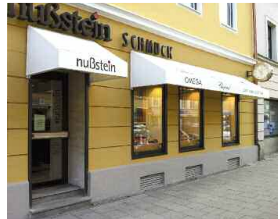
Seit Oktober 2013 erstrahlt die Fassade des Ladengeschäfts in der Tegernseer Landstraße 43 in neuem Glanz.
